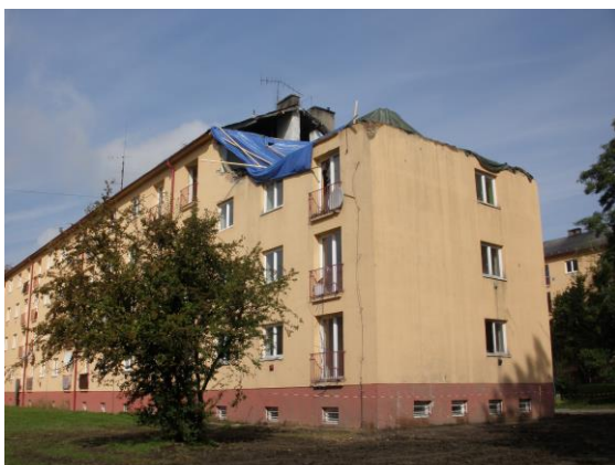
Obr. 7: Exploze zničila obvodové stěny bytu. Provizorní zajištění plachtou.
