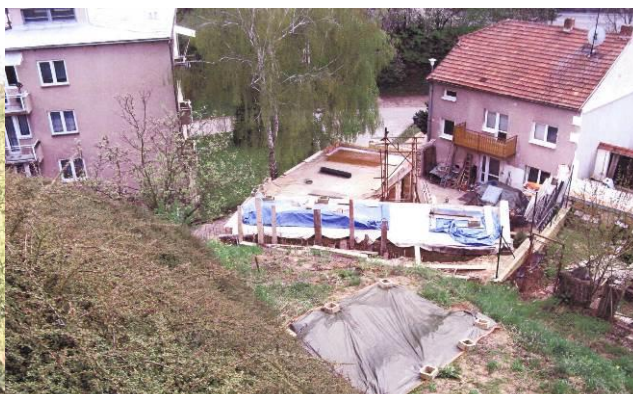
Obr. 4: Problematická stavební činnost v patě svahu (03-04/2010).
