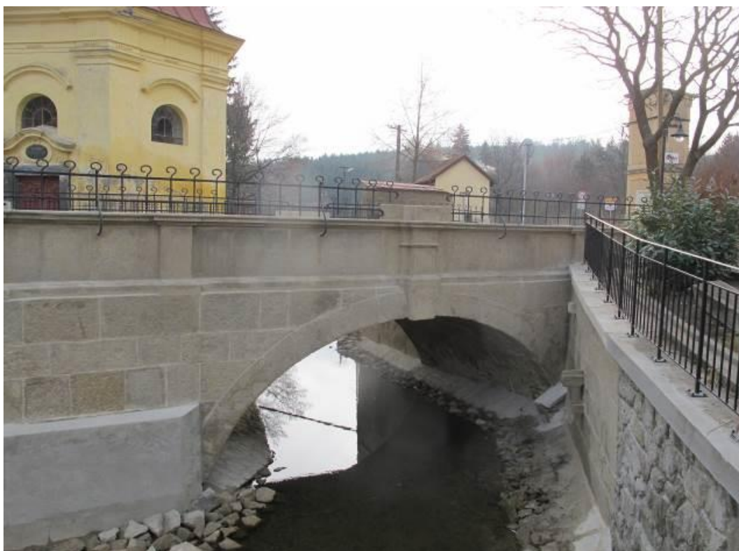
Obrázek 3: Parapet na vtoku před opravou a po opravě
