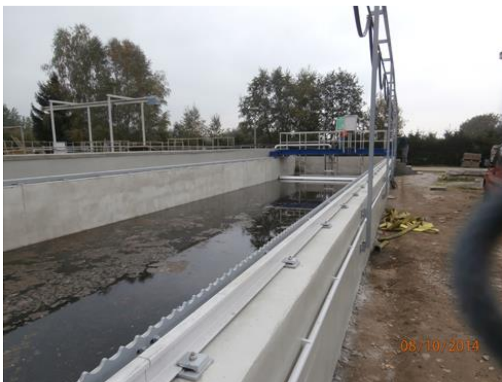
Obrázek 11.: Dokončená dosazovací nádrž vč. technologie po uvedení do provozu
