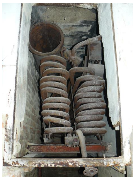
Obrázek 3.: Původní výměník tepla
