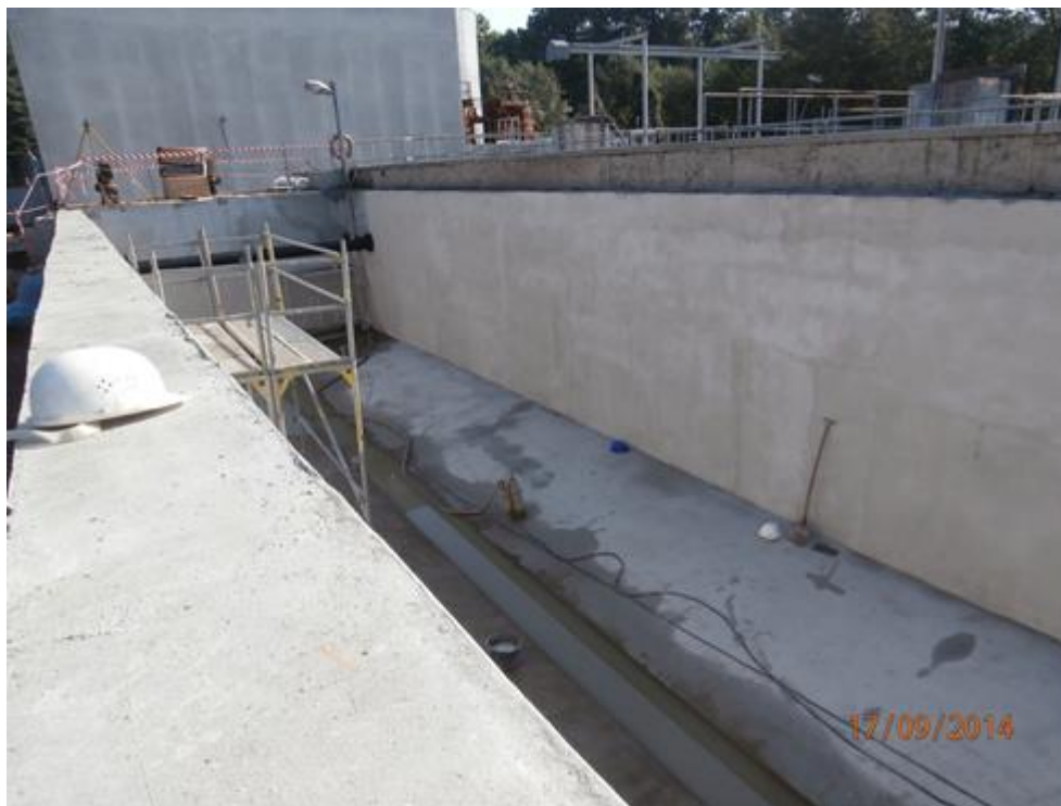
Obrázek 10.: Provádění sanace – dosazovací nádrž
