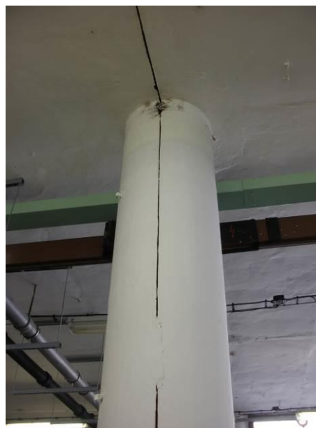
Obr. 2: Kruhový sloup na polovinu dělený dilatační spárou (tzv. „Bat'ův skelet“).
