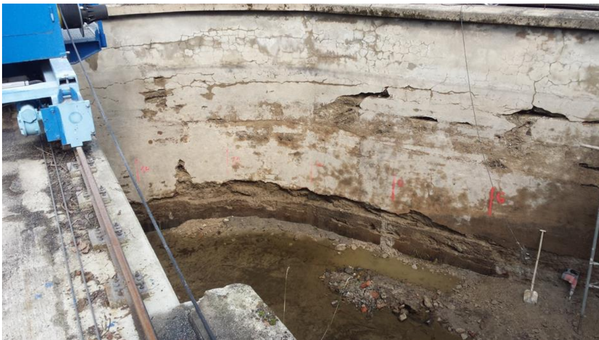
Obrázek 2.: Náhon stav po vyčerpání
