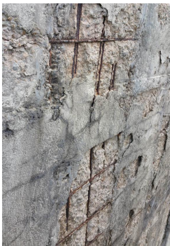
Obrázek 6.: Vnější povrch pláště věže s narušeným povrchem
