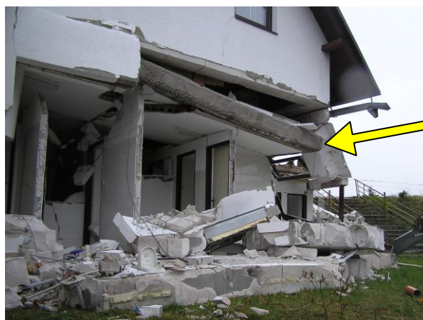
Obr. 4: Detail zničené čelní zdi. Věvec se odtrhl a visí v prostoru (šipka).
