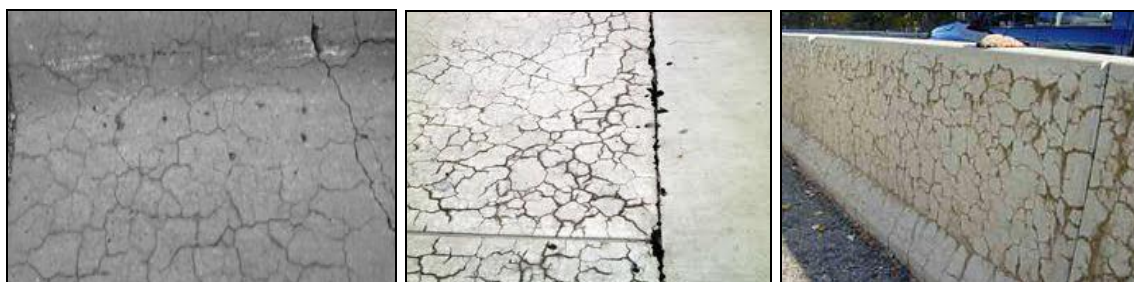
Obrázek 1.: zleva: síť trhlin na cementovém krytu vozovky; síť trhlin na jednom dilatačním celku; porušená Jersey bariéra na dálnici v USA
