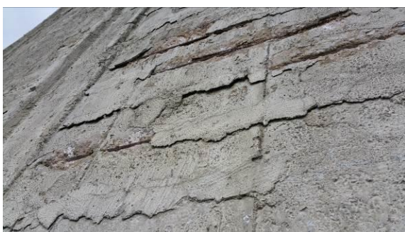
Obrázek 3.: Vnější povrch pláště věže s narušeným povrchem
