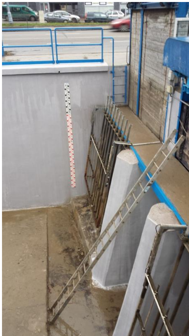
Obrázek 12.: Vzhled konstrukce po aplikaci nátěrů, náhon
