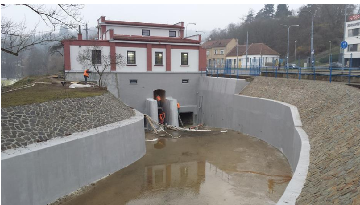
Obrázek 11.: Vzhled konstrukce po aplikaci nátěrů, odpadní koryto
