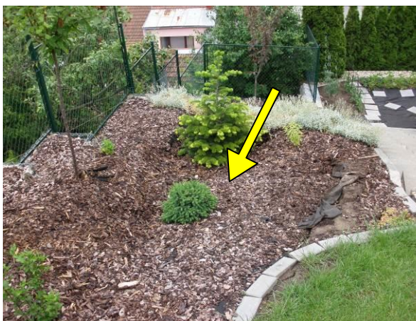
Obr. 15: Propad terénu za gabionovou zdí (šipka).
