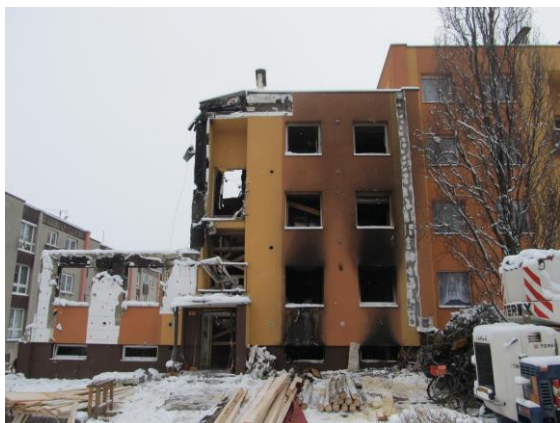
Obr. 5: Stav krajního domu po explozi. Levá část objektu je již odstraněna, konstrukce se zřítily. Provádějí se záchranné práce.
