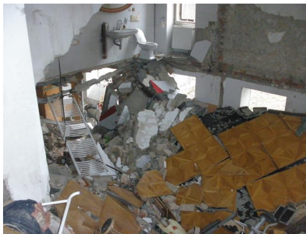
Obr. 10: Zřícený strop nad místem výbuchu.
