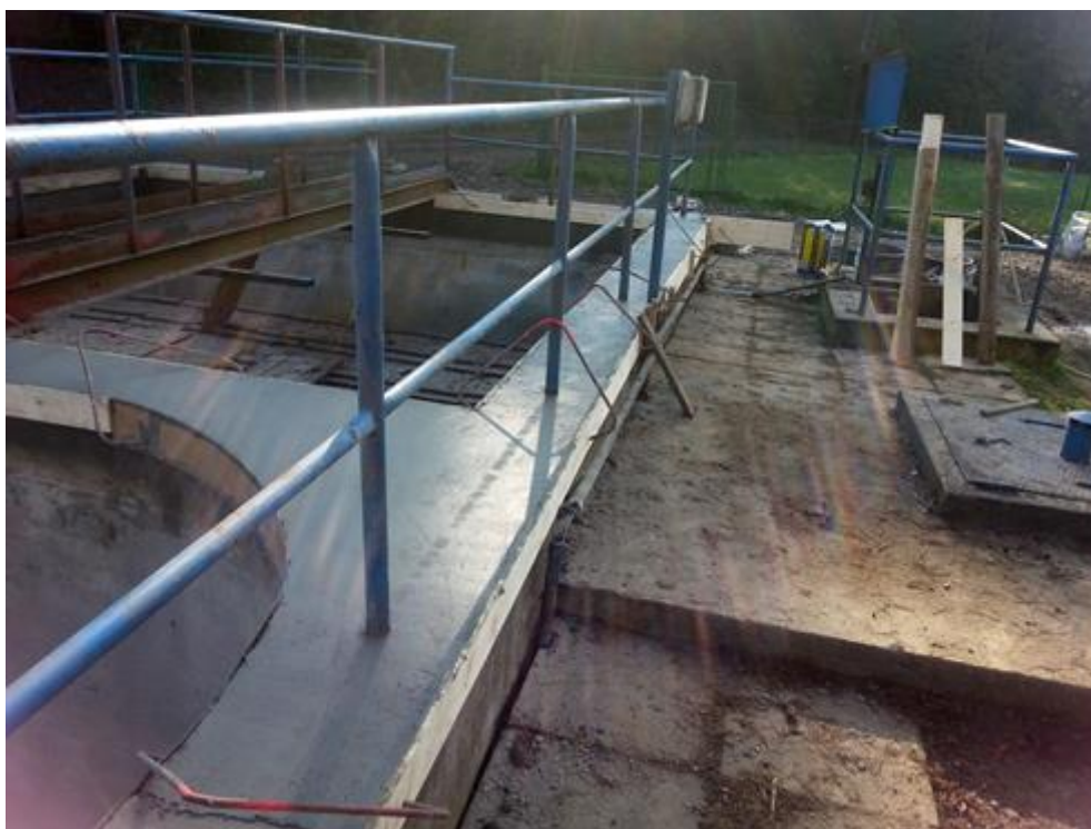
Obrázek 4.: Provádění sanace zhlaví nádrží
