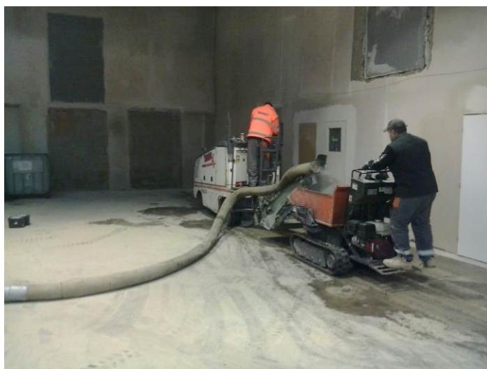
Obrázek 4.: Frézování porušeného povrchu
