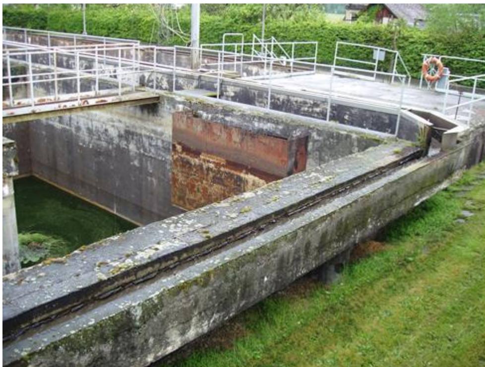
Obrázek 2.: Původní stav konstrukce
