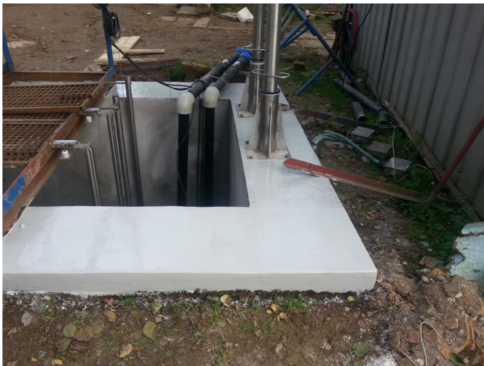
Obrázek 7.: Sanace čerpací jímky
