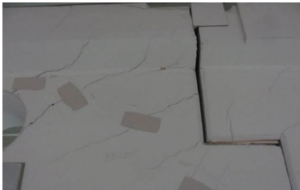
Obr. 10.: Spojení průvlaku - porušení trhlinami.
