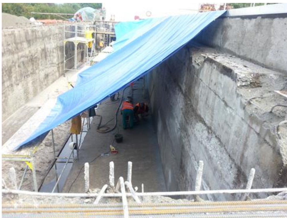
Obrázek 9.: Provádění sanace – dosazovací nádrž
