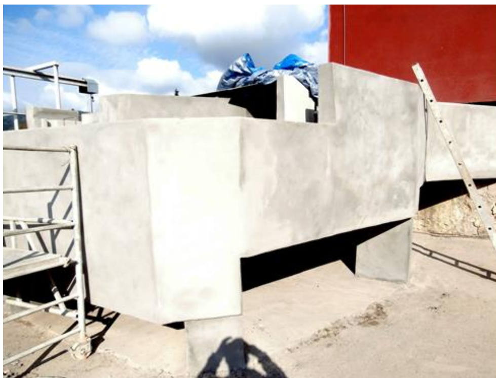
Obrázek 6.: Provádění sanace lapáku písku a přilehlých obtokových žlabů
