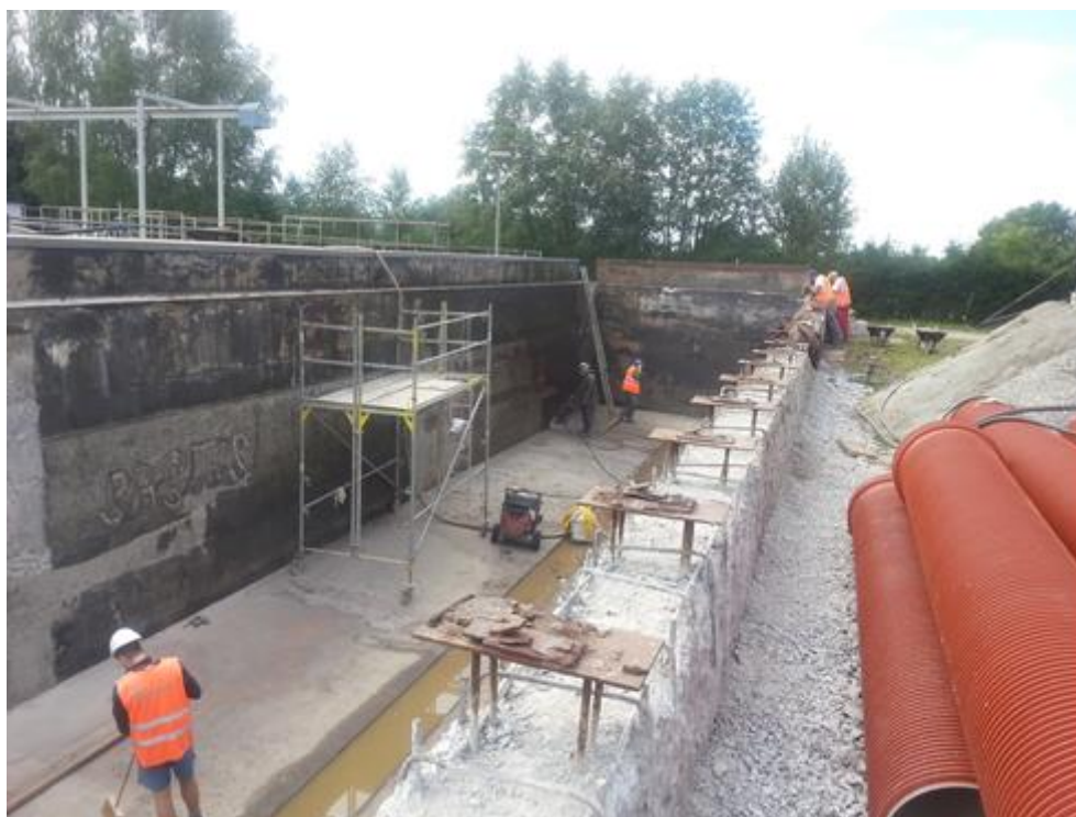
Obrázek 8.: Příprava povrchu pro sanace – dosazovací nádrž
