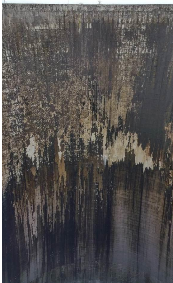
Obrázek 2.: Vnitřní povrch pláště chladicí věže
