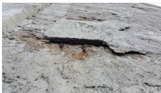
Obrázek 4.: Vnější povrch pláště věže s narušeným povrchem
