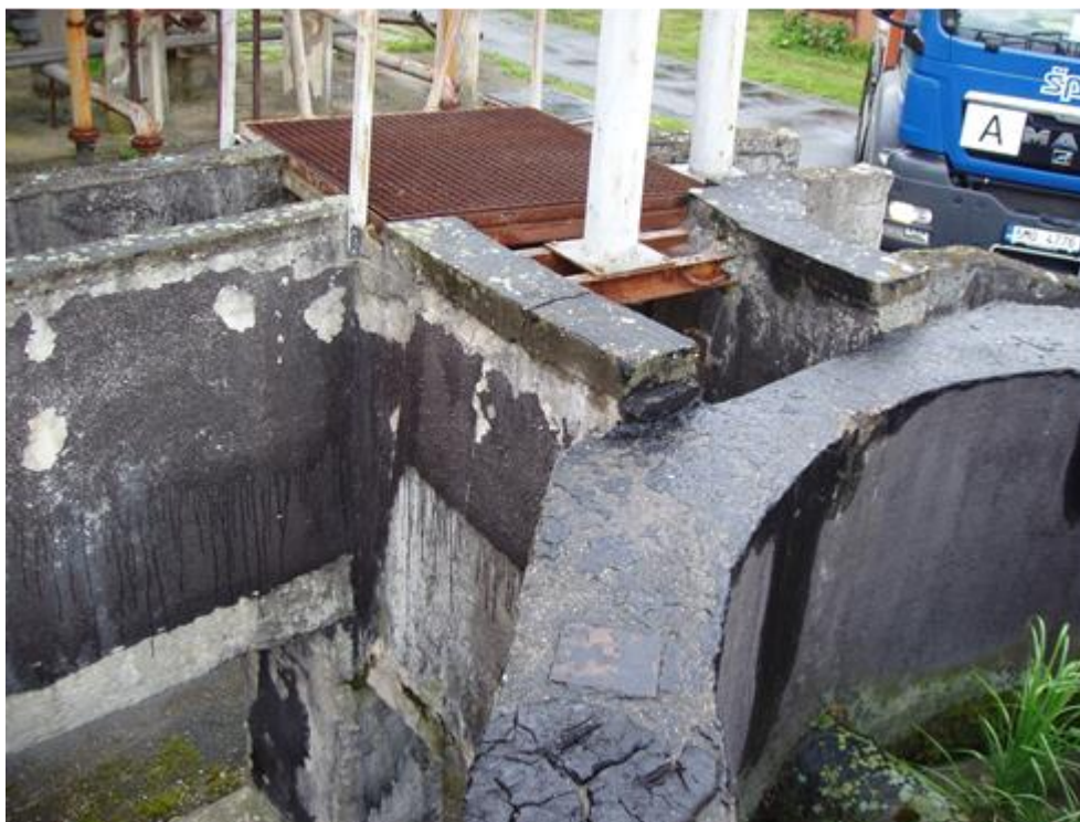
Obrázek 3.: Původní stav konstrukce
