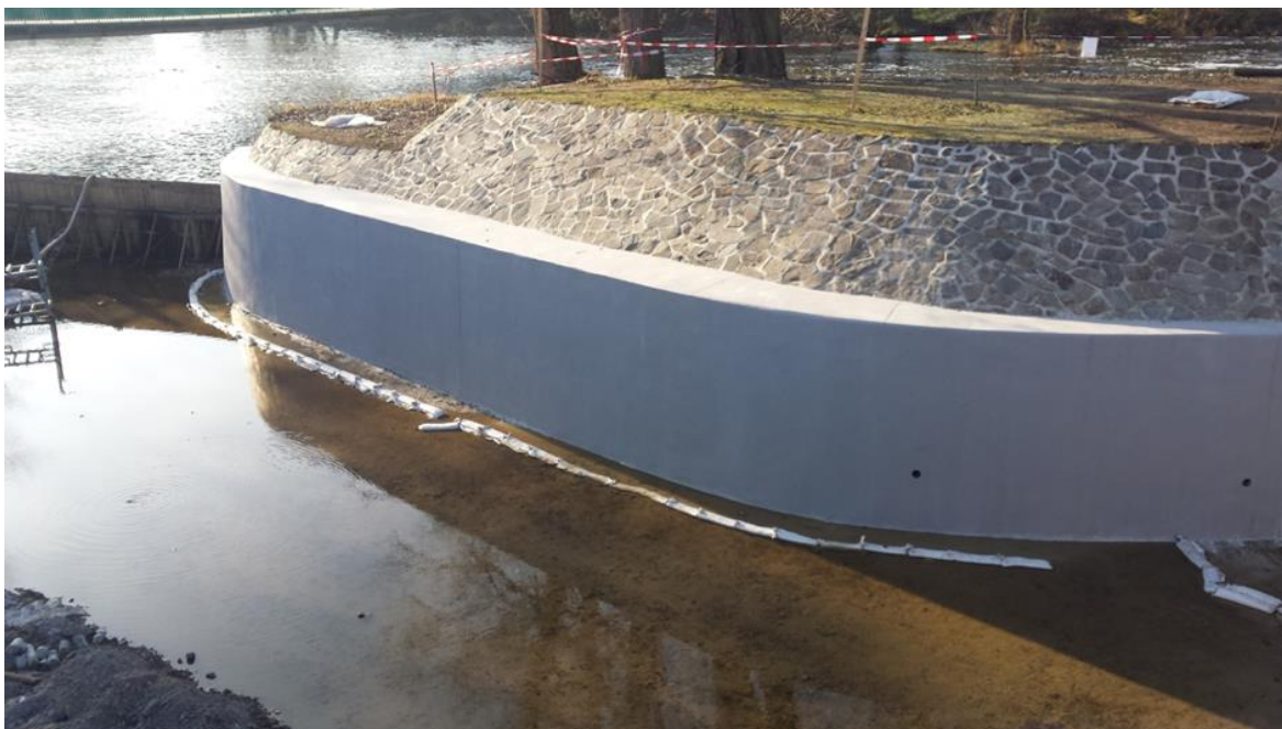
Obrázek 10.: Vzhled konstrukce po aplikaci nátěrů, odpadní koryto
