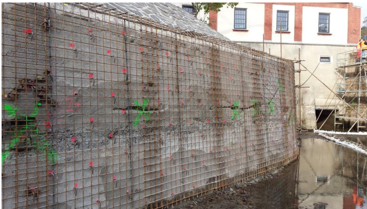
Obrázek 5.: Armování, odpadní koryto
