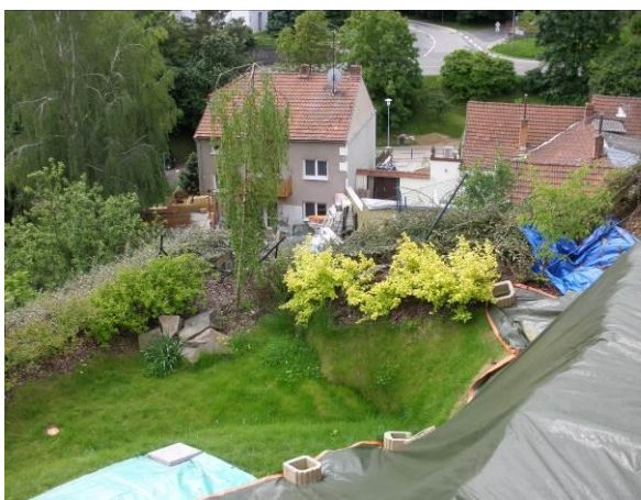
Obr. 9: Zdeformovaný a pokleslý svah. Pohled shora - viz i Obr. 4.
