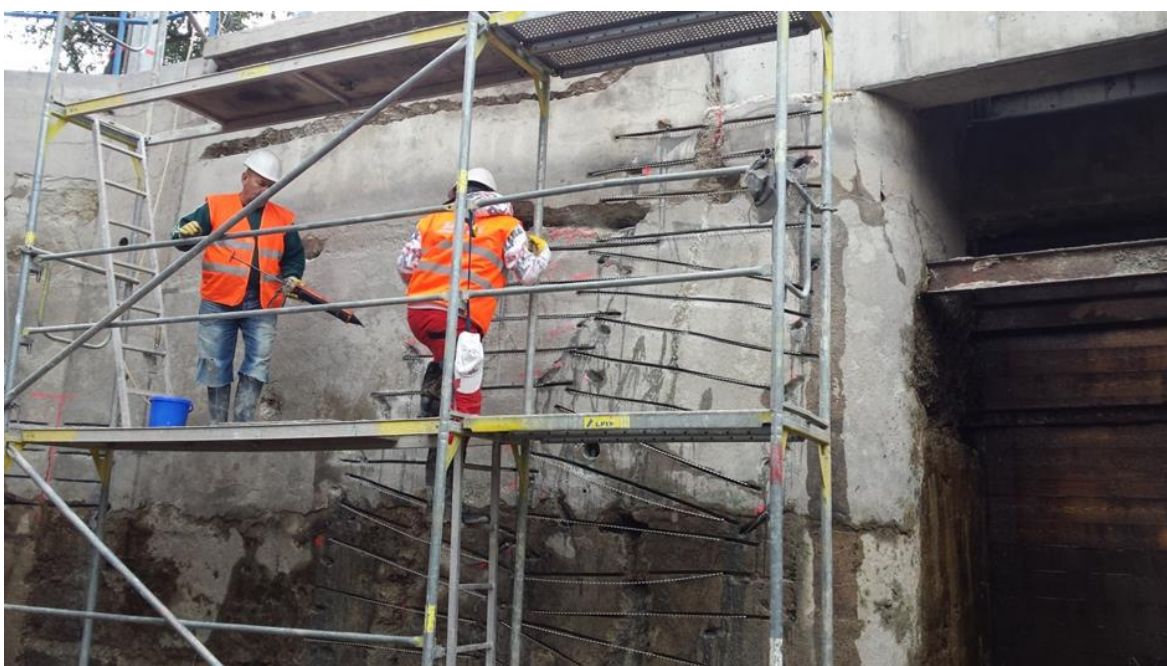
Obrázek 3.: Sešití a injektáž trhlin
