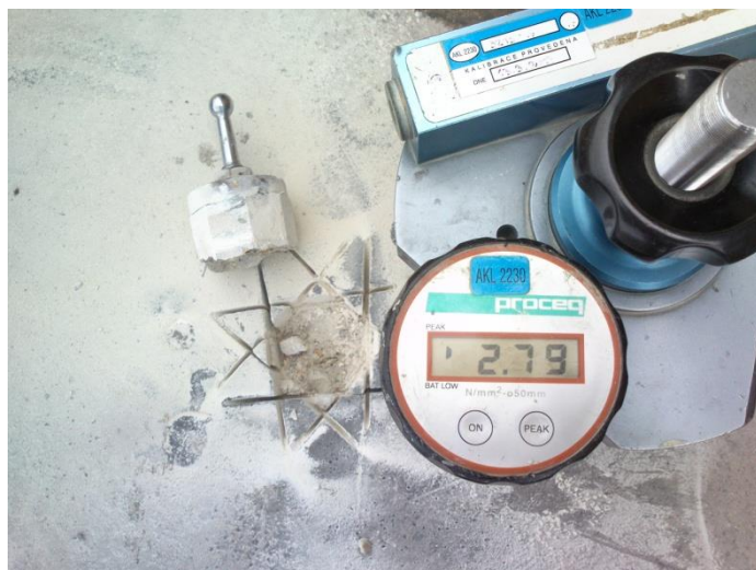
Obrázek 2.: Provádění zkoušky pevnosti v tahu povrchových vrstev betonu
