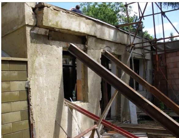
Obr. 13: Zemním tlakem poškozená čelní stěna stavby v patě svahu.
