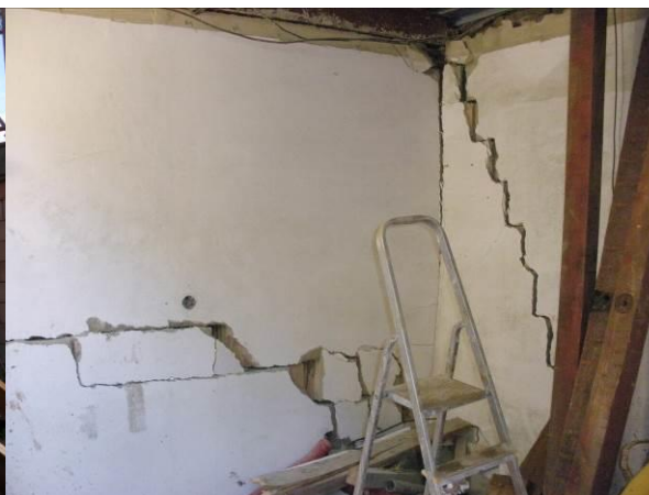
Obr. 14: Porušení vnitřních zdí mohutnými trhlinami u stavby z Obr. 4, 9, 13.
