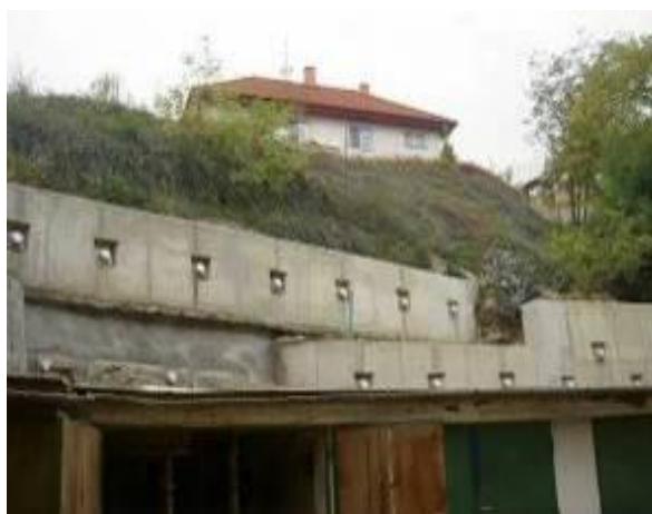
Obr. 18: Úprava (zajištění) svahu, realizované v září – říjnu 2010 [16].
