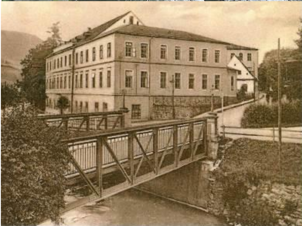
Obrázek 7.: Most ev.č. 375-001 Jimramov, Most ev.č. 36719-2 Dobromilice, Most ev.č. SU-002 Jeseník
