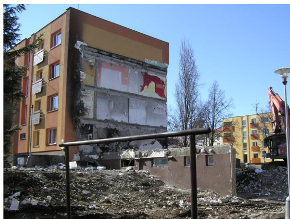
Obr. 6: Odstranění poškozeného domu. Zbývající dva domy byly staticky zajištěny pomocí předpjatých lan. Stažení provedla odborná firma.
