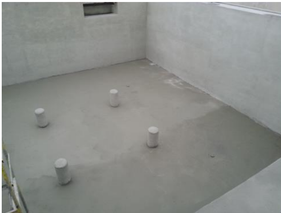
Obrázek 12.: Provádění sanace – aktivační nádrž
