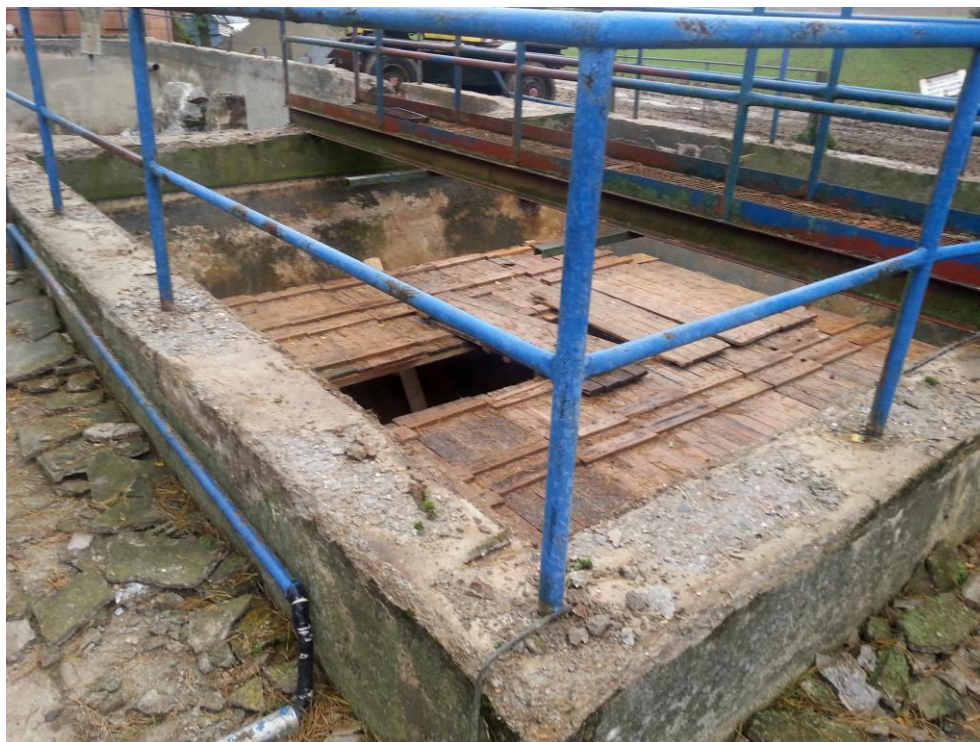
Obrázek 2.: Původní stav konstrukce
