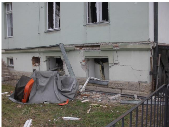
Obr. 9: Výbuchem vyboulené a roztrhané obvodové zdi.
