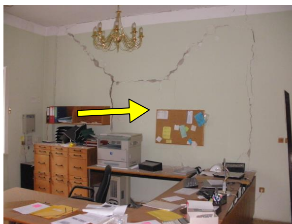
Obr. 2: Vnitřní zeď poničená výbuchem. Mohutné trhliny přes celou zeď, posuvy zdíva přes sebe (směr tlaku – šipka).
