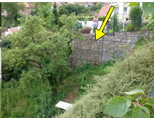
Obr. 16: Svahovým pohybem narušená gabionová zeď (šipka).
