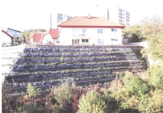
Obr. 3: Stav svahu po úpravě geotextíliemi (jaro 2003) [16].
