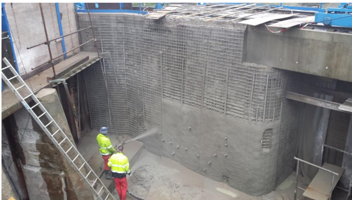
Obrázek 8.: Aplikace stříkaného betonu
