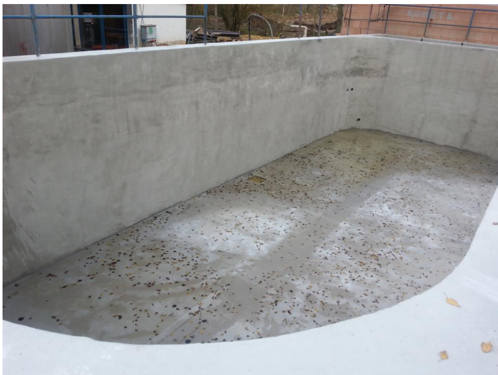
Obrázek 8.: Aktivační nádrž před instalací technologie
