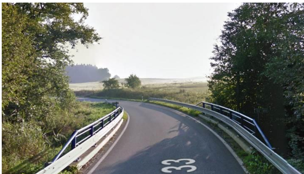
Obrázek 6.: Pohled na opěry a podhled nosné k-ce a most po opravě-současný stav
