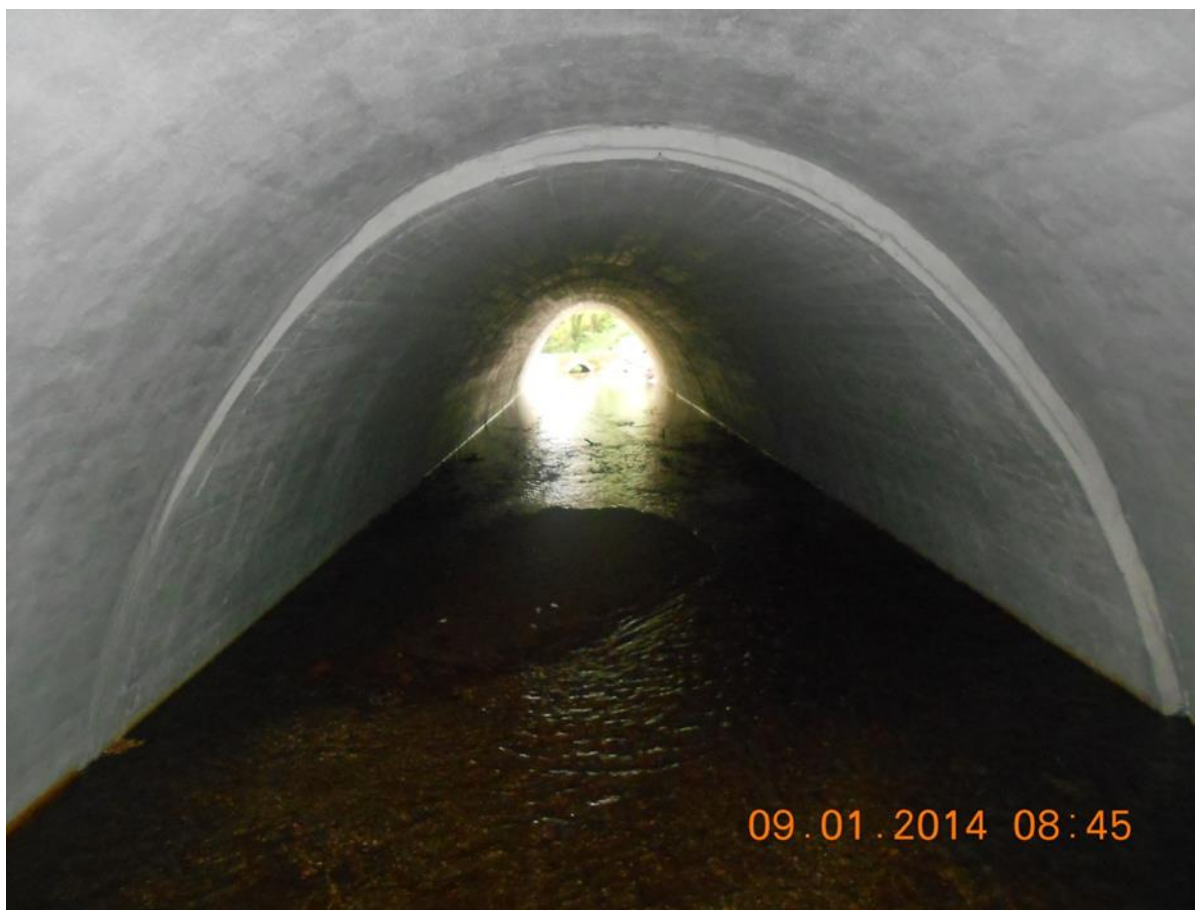
Obrázek 2.: Objekt SO 201 po sanaci
