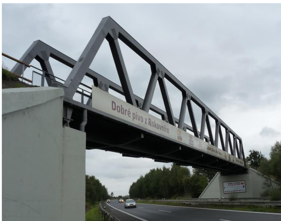
Obrázek 3.: Most SO 202 po rekonstrukci
