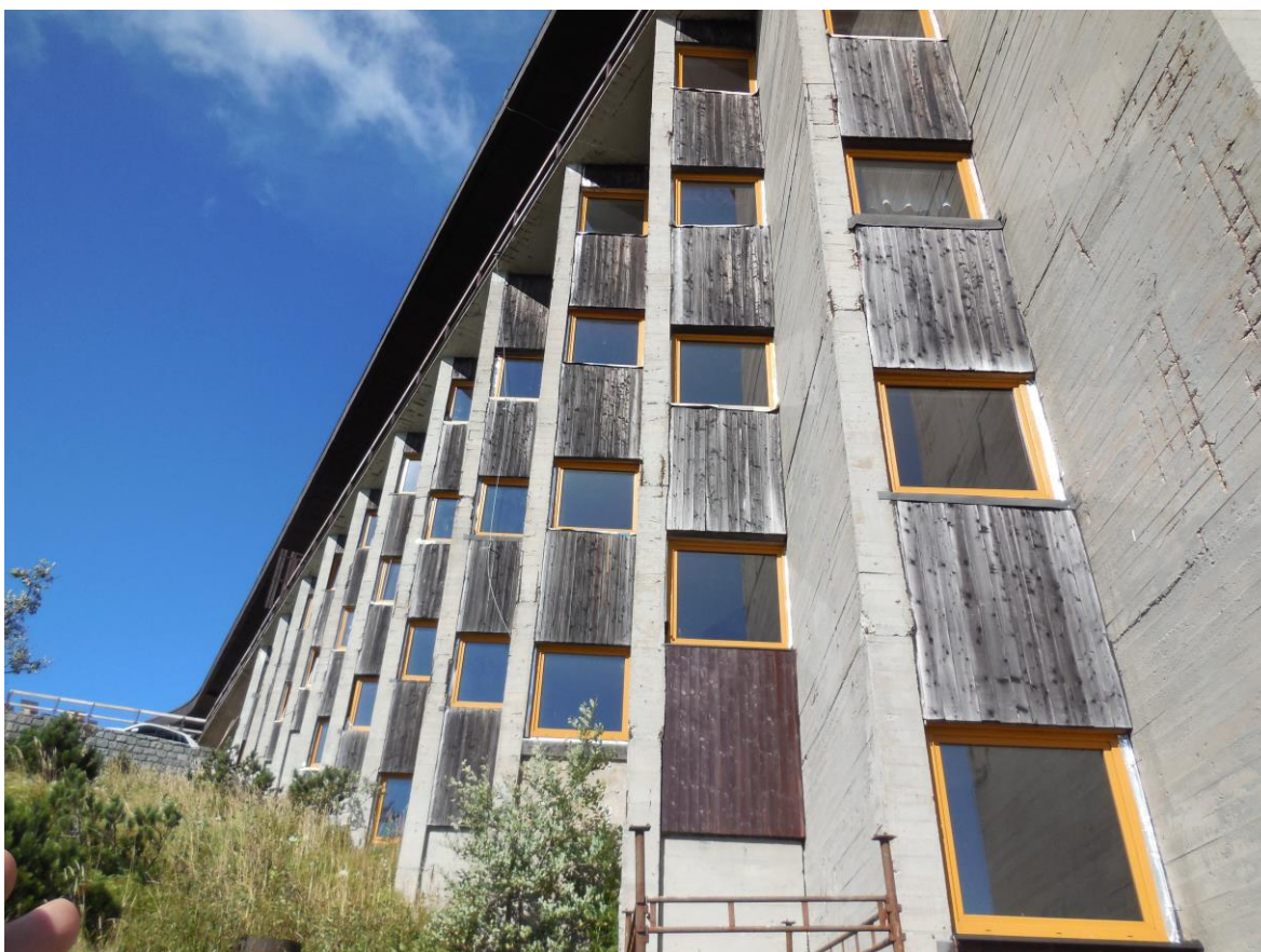
Obrázek 2.: Pohled na degradovaný betonový povrch
