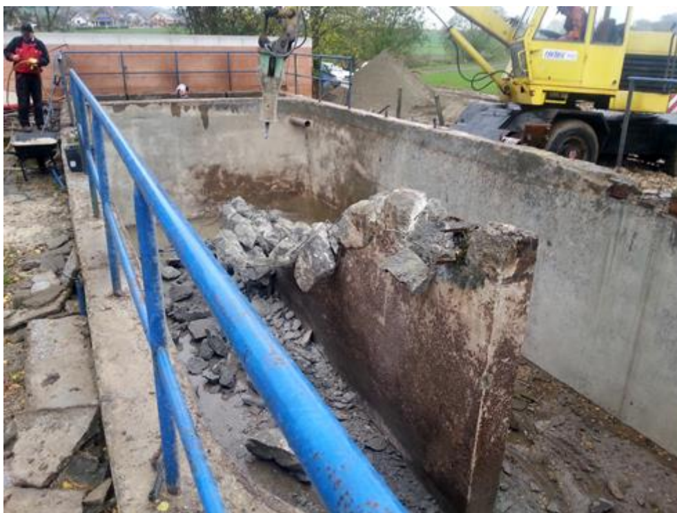
Obrázek 3.: Bourání dělící příčky v aktivační nádrži
