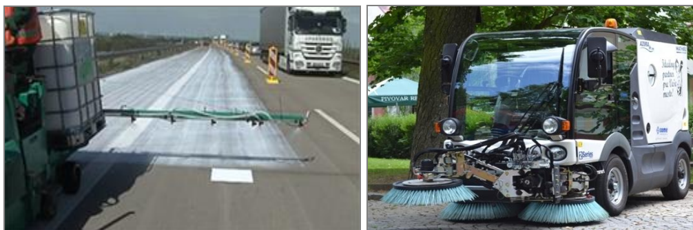
Obrázek 5: zleva: aplikace nástřikem; nástřikem s následným kartáčováním
