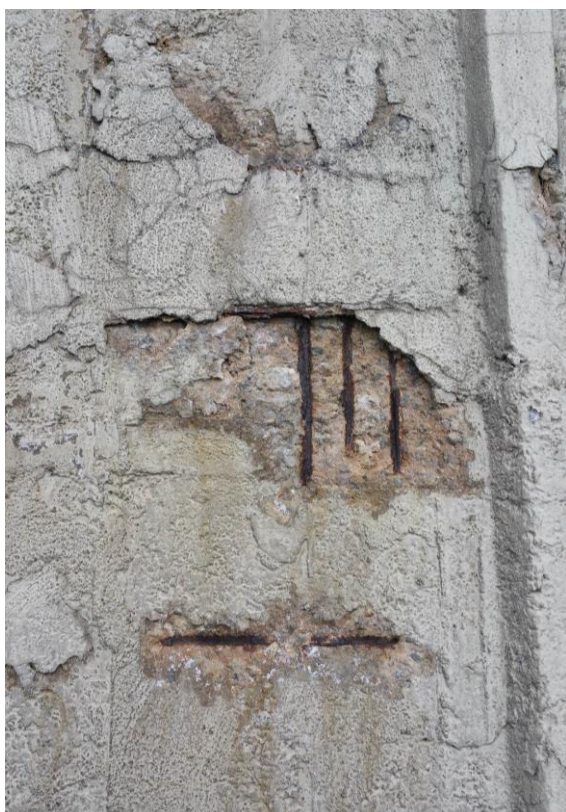
Obrázek 5.: Vnější povrch pláště věže s narušeným povrchem
