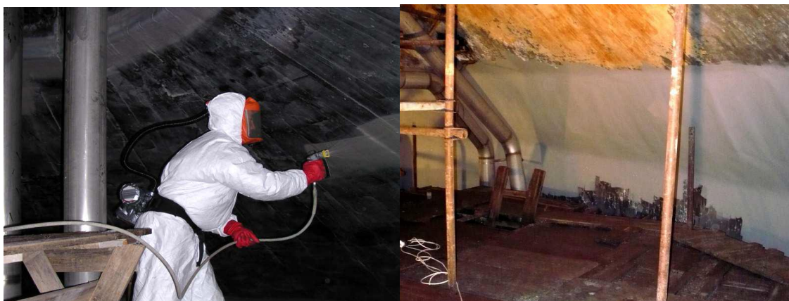
Obrázek 4.: Vyhřívací nádrže ČOV Litvínov
