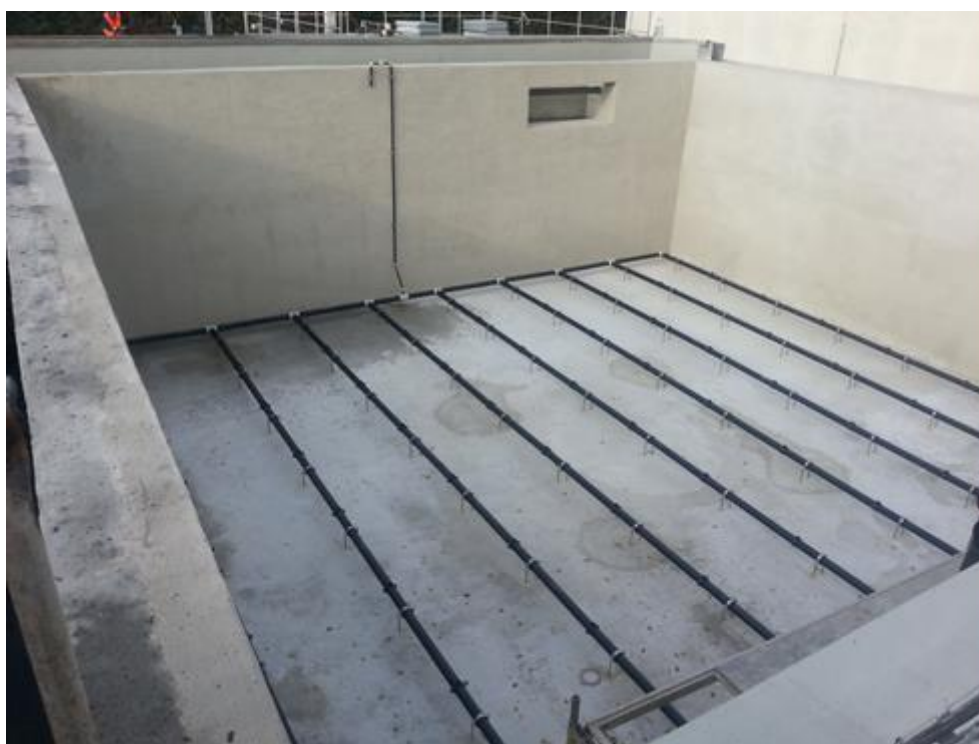
Obrázek 13.: Aktivační nádrž vč. nově osazené technologie dmýchání
