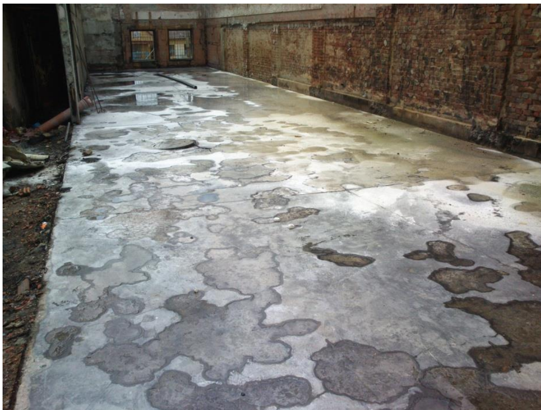
Obrázek 1.: Pohled na betonovou desku - povrch je vlivem prudké expanze páry narušen
