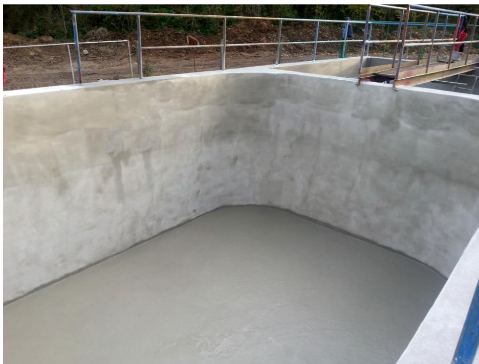
Obrázek 5.: Sanace aktivací nádrže
