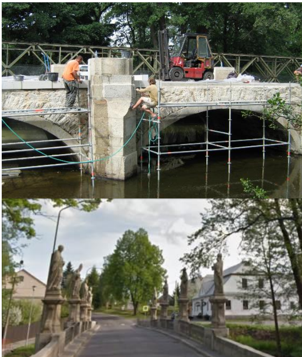
Obrázek 5.: Průběh kamenických prací a most po opravě-současný stav
