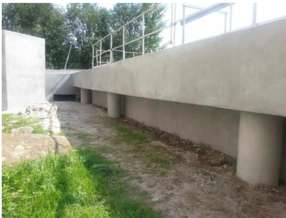
Obrázek 7.: Sanace žlabu vratného kalu
