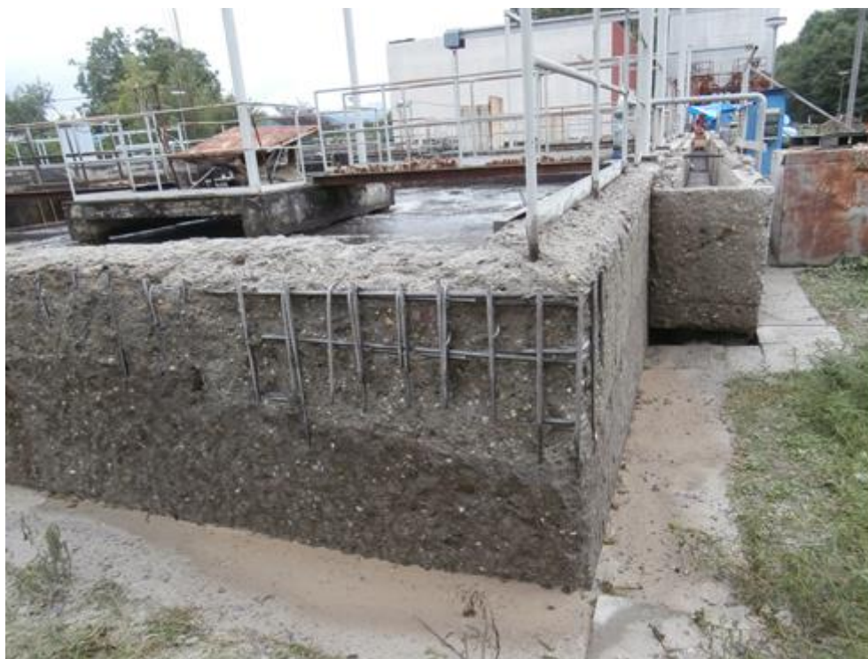
Obrázek 4.: Očištěná konstrukce pro provádění sanace
