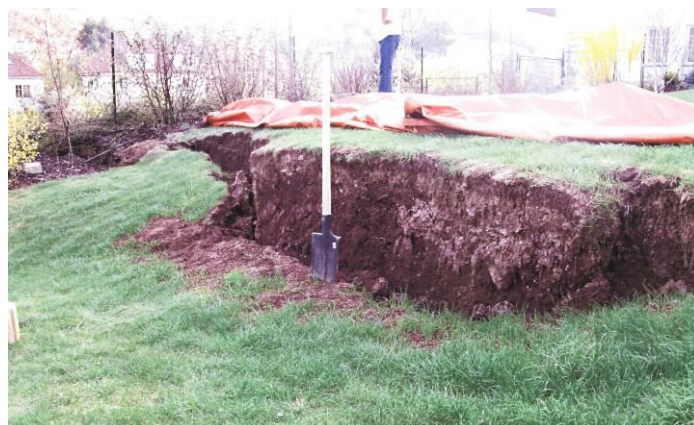
Obr. 6: Mohutný výškový odtrh (pokles max. až 4 m) a posuv v koruně svahu. Vlevo ve spádu jsou uloženy geotextílie
