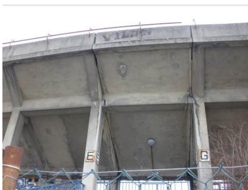
Obr. 9: Fotbalový stadion, dilatace tribuny (vložené pole).
