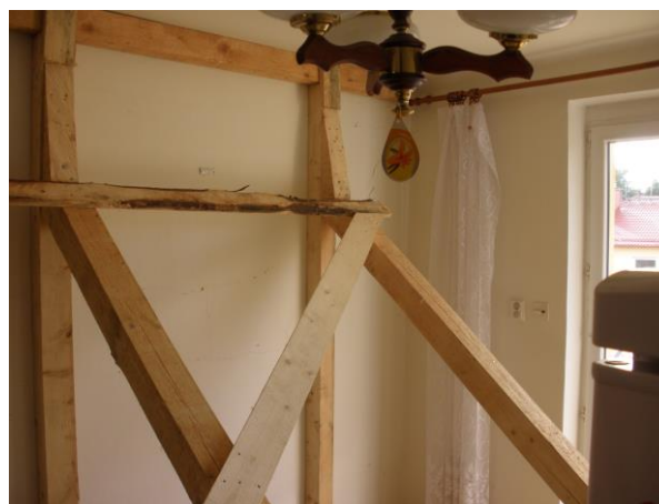
Obr. 8: Provizorní vydřevení ve vedlejším bytu.
