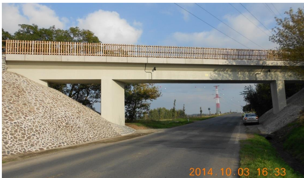
Obrázek 6.: Pohled na dokončený most SO 203
