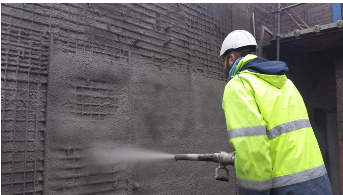
Obrázek 6.: Aplikace stříkaného betonu
