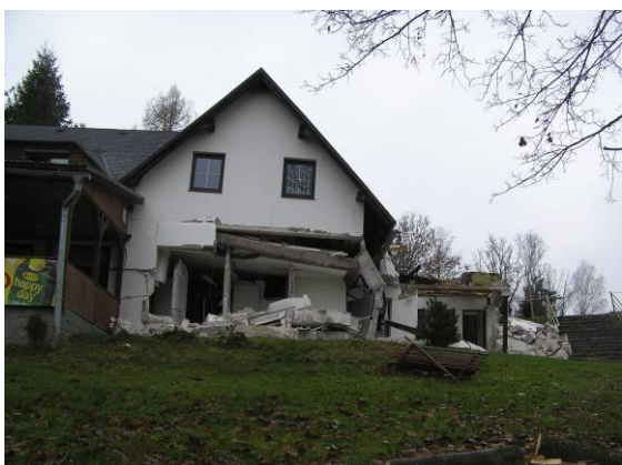
Obr. 3: Výbuch vytrhl a vyhodil kusy zdiva mimo stavbu.
